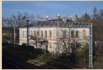
Zdjęcie budynku mieszkalnego również autorstwa Marconiego w Maczkach. Fot. Bartosz Gawlik.
