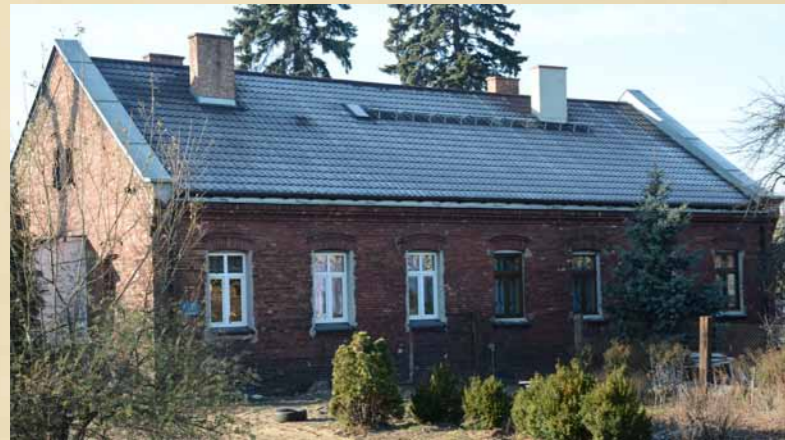
Poraj dwurodzinny budynek przy ul. Kolejowej wybudowany w 1848 roku dla urzędników Kolei Warszawsko – Wiedeńskiej – ujęcie od wschodu. Fot. Grzegorz Onyszko.
