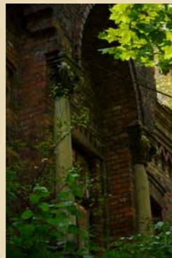
Fragment budynku z widocznymi szczegółami architektonicznymi w tym godłem Drogi Żelaznej Warszawsko-Wiedeńskiej. Fot. Bartosz Gawlik.
