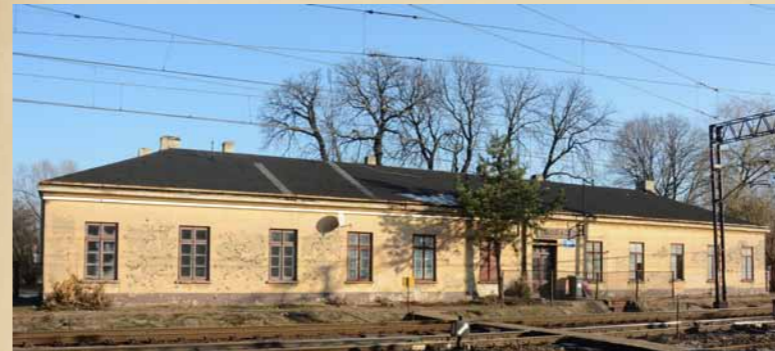
Poraj. Budynek starego dworca III klasy proj. Henryka Marconiego – ujęcie od zachodu. Fot. Grzegorz Onyszko.
